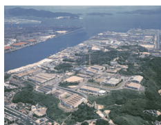
「福山テクノ工業団地」全景 (写真提供：福山熱煉工業株式会社)
